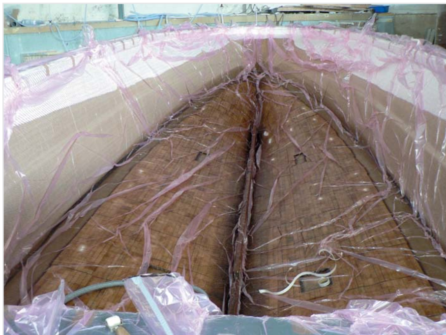
Fût dans lequel le tuyau aspire la résine qui est diffusée dans les tissus de verre.
